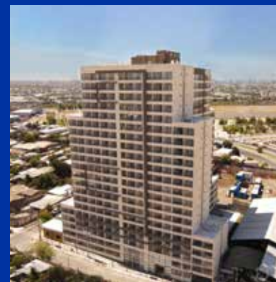
Edificio Martín de Solier 4540 Cerrillos
